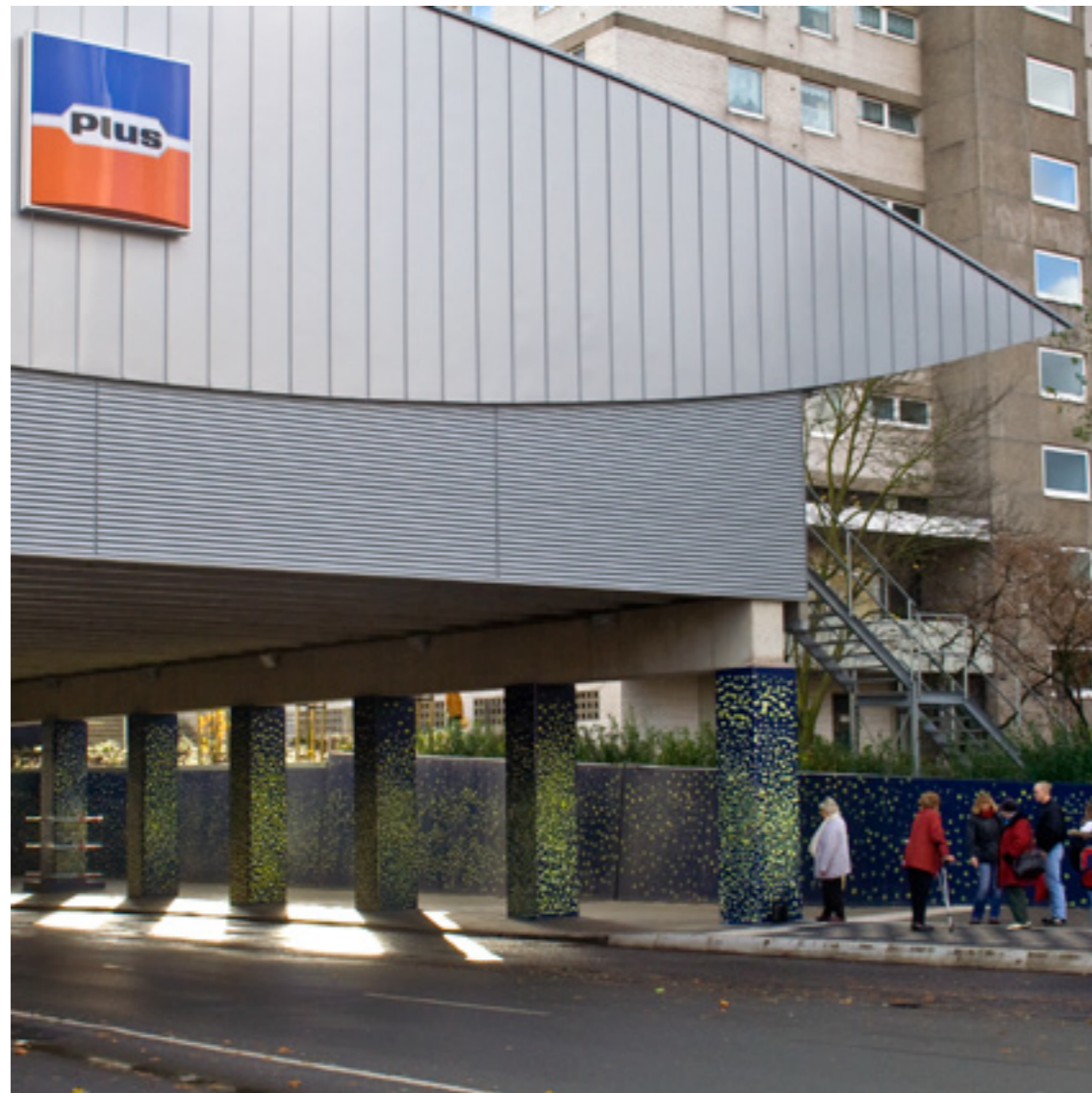
Sternenhimmel Gestaltung der Haltestelle Düsseldorf Garath Westseite unter der von der Bauunternehmung Tecklenburg-Immobilien errichteten Plusfiliale.
